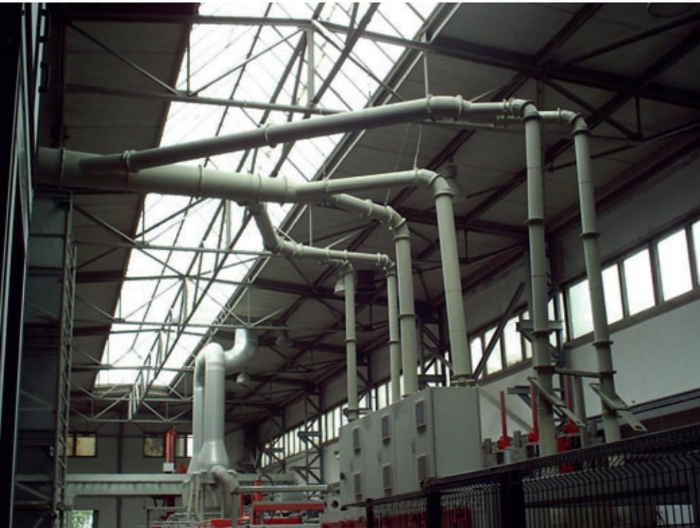
Verrohrungen zu den separat stehenden Absaug-, bzw. Filteranlagen
