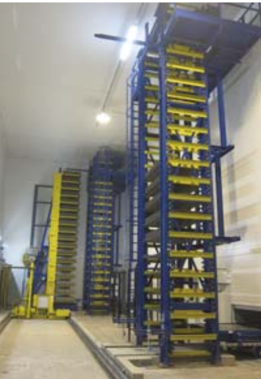
Przekazanie stwardniałych wyrobów betonowych do windy rozpiętrowującej na linii suchej.
