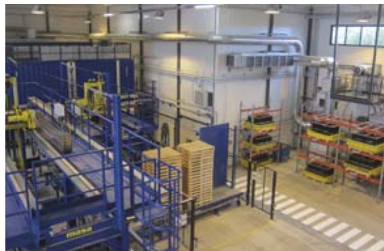
Fińskie zimy są długie i surowe. Aby mimo tego zapewnić ciągłość produkcji, całą halę obłożono elementami izolacyjnymi o podwyższonej ognioodporności.
