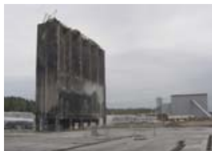
Po pożarze zakład był zupełnie zniszczony. Udało się odratować jedynie betonowe zasobniki na kruszywo.
