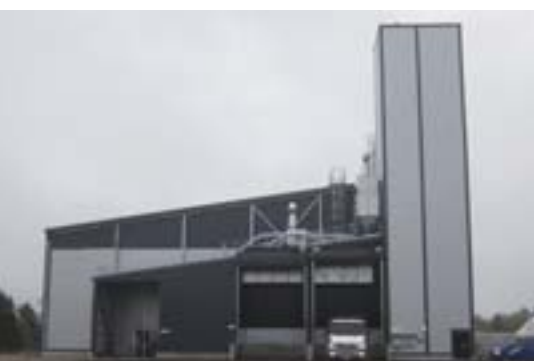
Nowo wybudowany zakład produkcji betonowych bloczków w Oitti.
