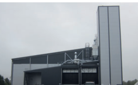
Lo stabilimento per la produzione di blocchi in calcestruzzo, appena realizzato, ad Oitti
