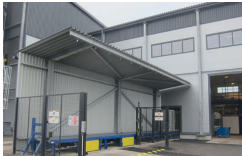
Ad Olti non si è risparmiato in termini di tecnica della sicurezza. Tutte le stazioni sono state progettate e realizzate secondo standard di sicurezza molto elevati.
