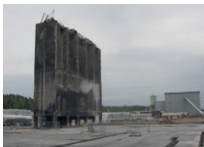
Lo stabilimento era completamente distrutto dopo l'incendio. Soltanto i silos per il calcestruzzo poterono essere conservati.
