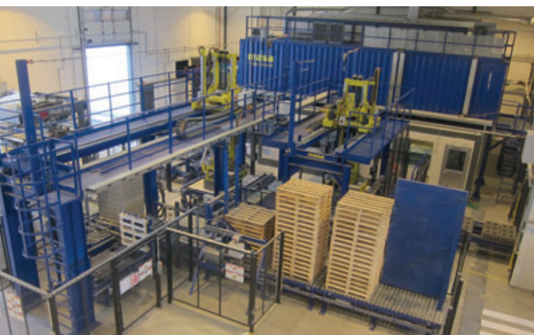
Clairement agencée et dotée d'une technique de sécurité complète. La nouvelle usine de fabrication de blocs de béton Masa chez Saint-Gobain Weber à Oitti, Finlande
