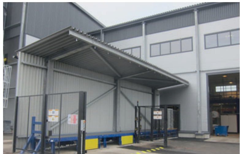
Aucune concession n'a été faite sur la technique de sécurité à Oitti. Tous les postes de travail ont été planifiés et réalisés d'après des normes de sécurité très élevées.
