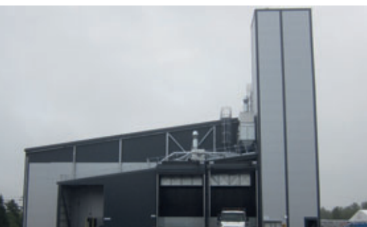
La nouvelle usine de fabrication de blocs de béton à Oitti
