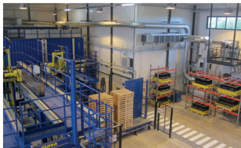
Les hivers en Finlande sont longs et rigoureux. Afin de garantir tout de même une production continue tout au long de l'année, l'ensemble du hall a été doté d'un habillage composé d'éléments isolants faiblement inflammables.
