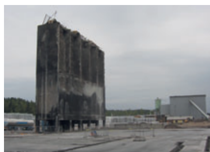
L'usine a été totalement détruite suite à un incendie. Seuls les silos à béton ont pu être conservés.
