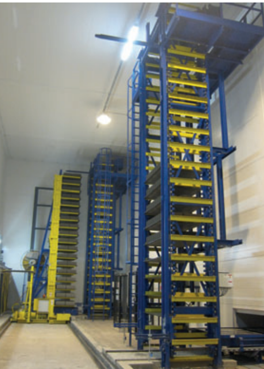
Remise d'articles en béton durcis au descendeur situé côté sec
