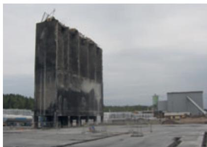
Nach dem Brand war das Werk vollständig zerstört. Lediglich die Betonsilos konnten erhalten werden.
