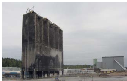
大火摧毁了整个工厂，只有混凝土骨料仓得以存留
