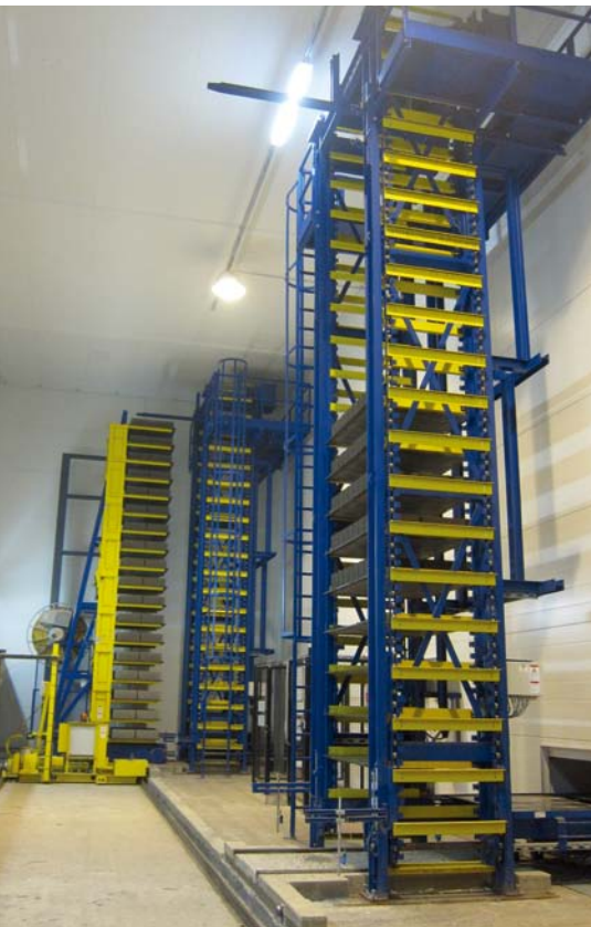
转运硬化的混凝土制品至干燥端的降落装置
