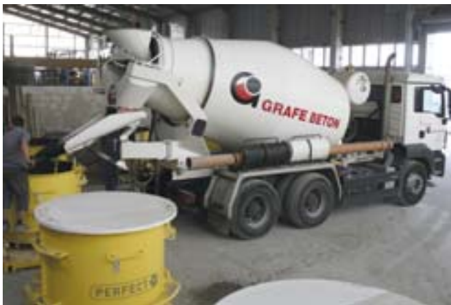
Mieszanka betonowa jest dostarczana do hali betoniarki samochodowej z własnej floty pojazdów.
