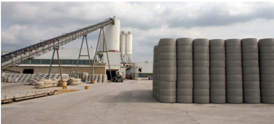
Lo stabilimento di Stölpchen della Tamara Grafe Beton GmbH
