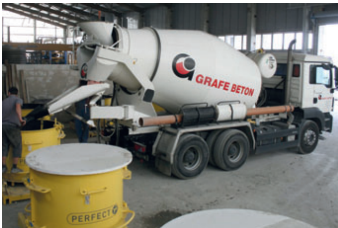
Una betoniera trasporta il calcestruzzo agli stampi.
