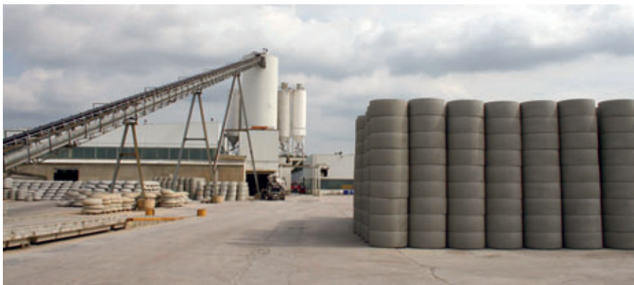
Le site de la société Tamara Grafe Beton GmbH à Stölpchen.
