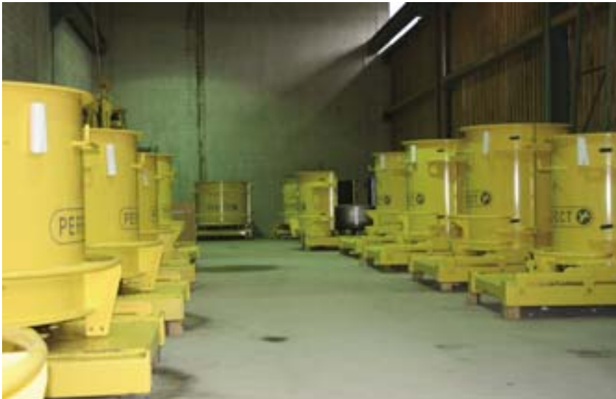
W pierwszej fazie zakład Rhomberg został wyposażony w 16 form Perfect wypełnianych betonem samozagęszczalnym.
