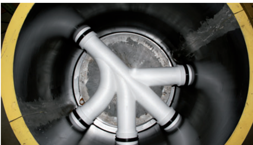
Anche nel fondo del pozzetto < DN1000 vengono riuniti più accessi - nell'immagine uno stampo armato per un fondo di pozzetto DN800.
