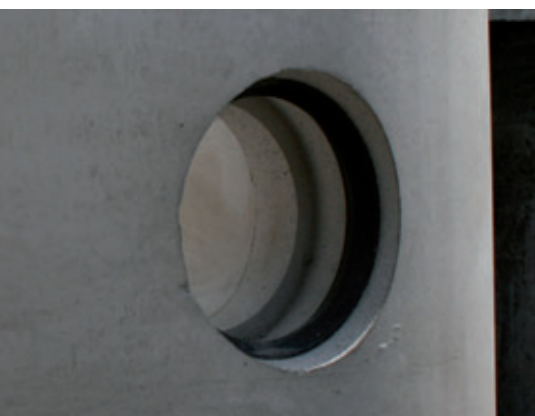
Le guarnizioni integrate saldamente nel calcestruzzo garantiscono raccordi a tenuta ermetica per tutti i tipi di tubi standard.
