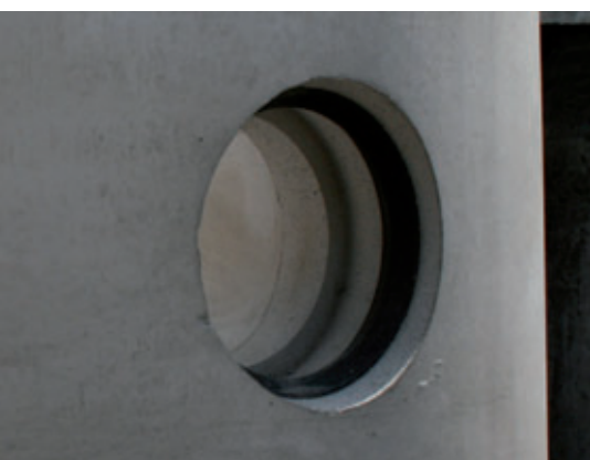
Des joints d'étanchéité solidement ancrés dans le béton garantissent des raccords étanches pour tous les types de conduites courants.
