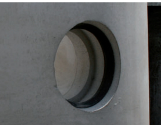
Fest im Beton integrierte Dichtungen sorgen für dichte Anschlüsse aller gängigen Rohrtypen.
