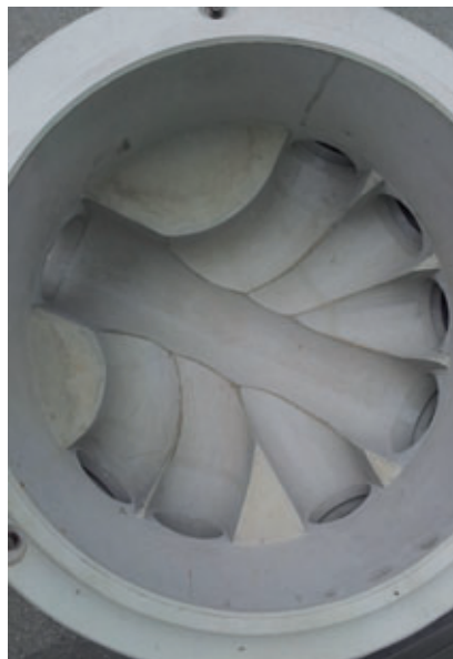
Eine Vielzahl an Rohranschlüssen im Schacht ist charakteristisch für den Kanalbau in Vorarlberg, im Bild ein Bauteil für die Ortskanalisation Dornbirn.
