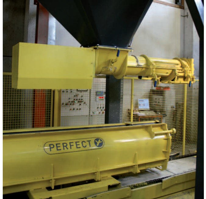
Через передаточную воронку бункера непрерывно поступает самоуплотняющийся бетон
