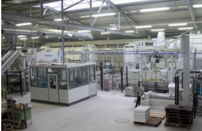
Bild 8: Blick in Produktionshalle mit Strahlanlage
