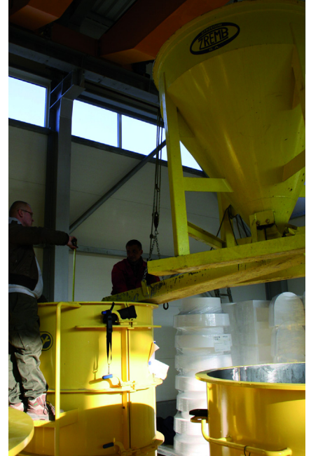
Бетонирование осуществляется с помощью подкрановой бады
