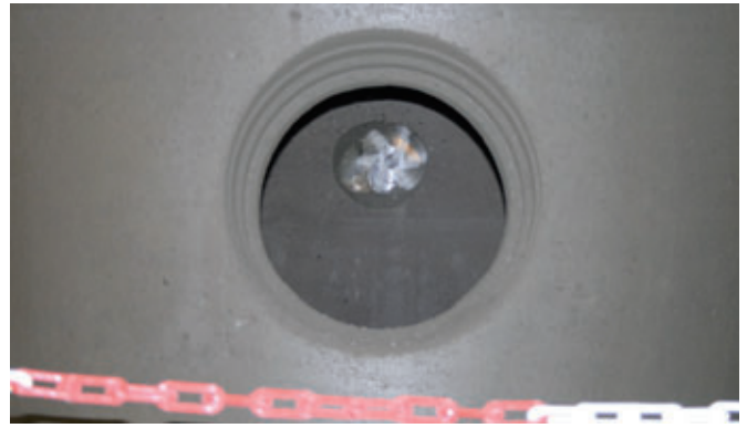
Les raccords de canalisations sont fraisés en cercle.
