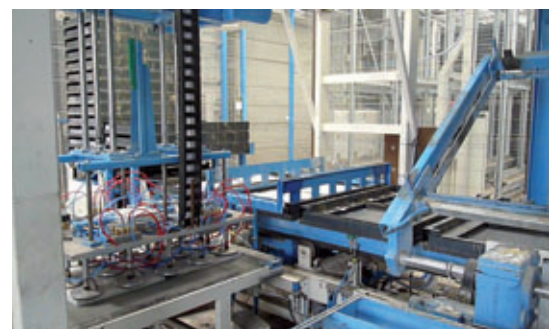
Les produits démoulés sont déposés sur un transporteur à bande
