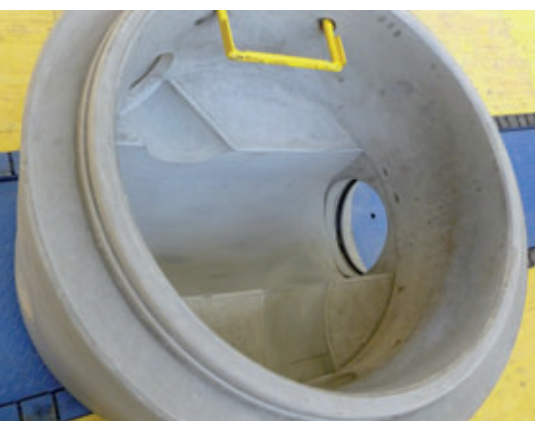
Fond de regard terminé avec échelon déjà en place
