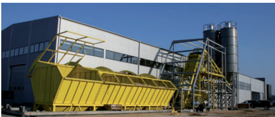
Le nouveau bâtiment de production de Ritbet pour Perfect. Les panneaux d'isolation de la centrale à béton pour le fonctionnement en hiver étaient encore en cours d'installation quand la production a démarré
