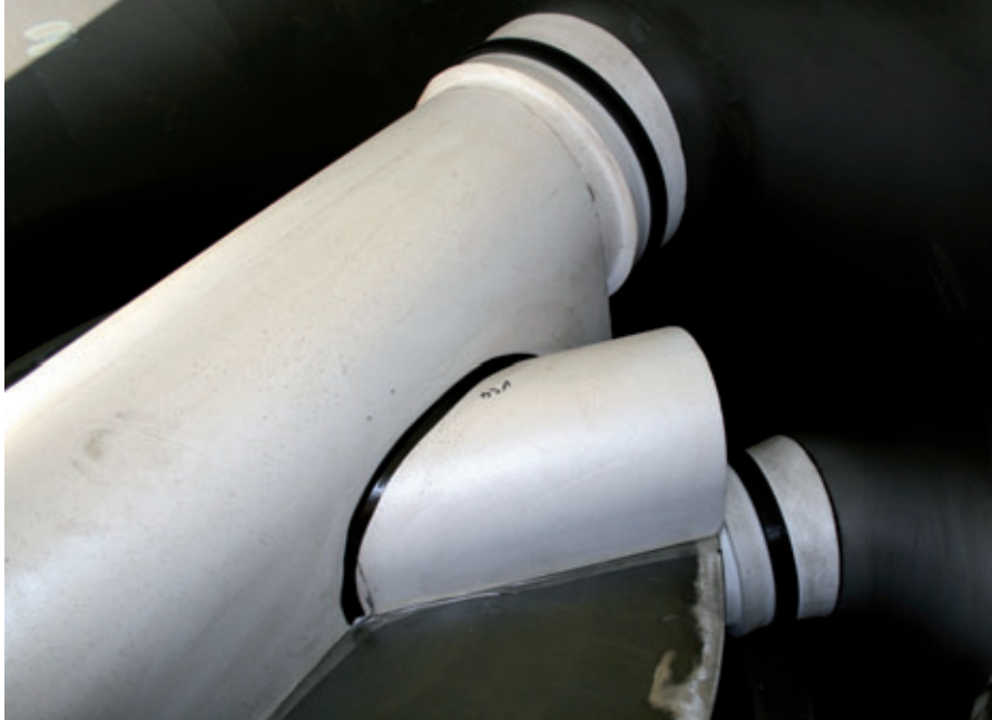
Cunette négative prête et fixée dans le moule déjà fermé. À droite une chute typique de la région avec le branchement tuyau situé au-dessus de la cunette
