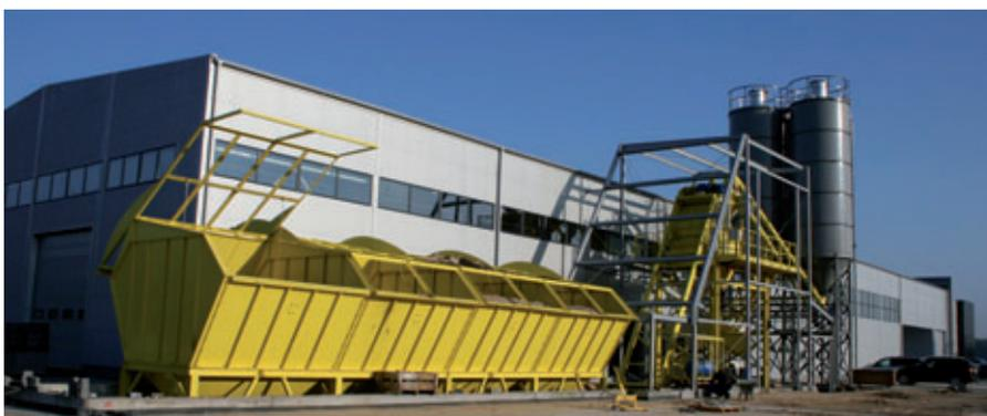
Die neue Produktionshalle für die Perfect-Fertigung bei Ritbet. An der Mischablage waren die Verkleidungen der Isoliereinhausung für den Winterbetrieb kurz nach Produktionsstart noch in Arbeit.
