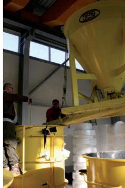
Betoniert wird mit Kübel und Kranbahn.
