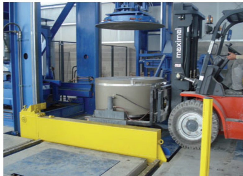
Entnahme des Bodenteilrohlings aus der Tornado
