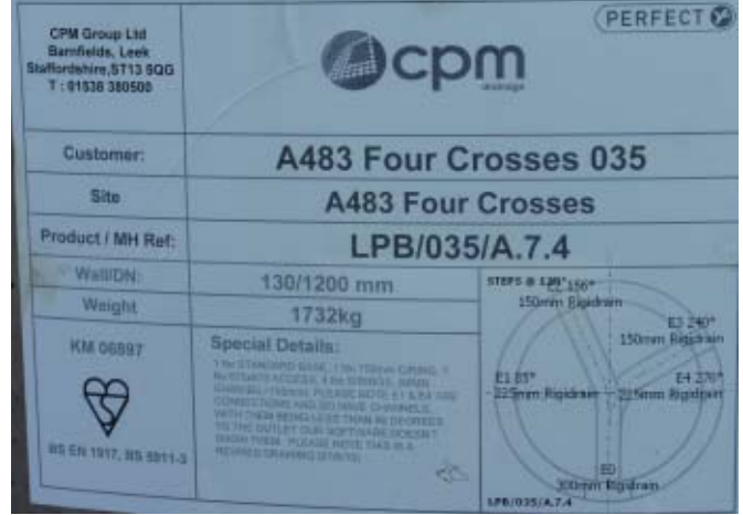
Информационные этикетки со всеми важными данными по проекту сопровождают деталь от стола проектировщика через весь процесс производства к строительной площадке
