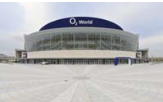
Projekt, w którym wykorzystano wielkoformatowe płyty brukowe.
