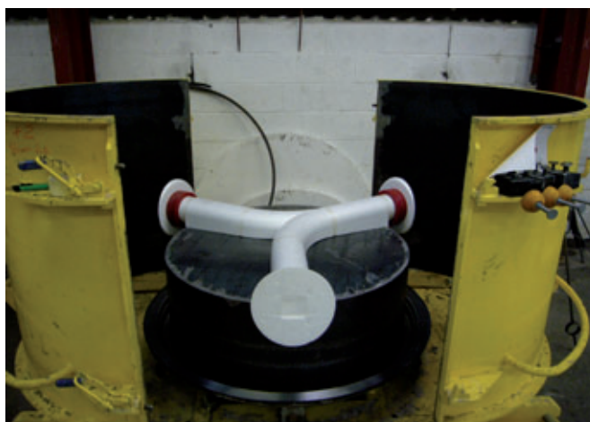
I canali di scolo in schiuma rigida in polistirene espanso vengono posizionati nei gusci d'acciaio per il versamento finale con il cemento autocompattante.
