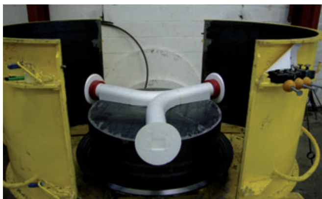
Les matrices des cunettes en mousse rigide de polystyrène expansé sont placées dans des coques en acier, lesquelles sont ensuite remplies de béton auto-plaçant
