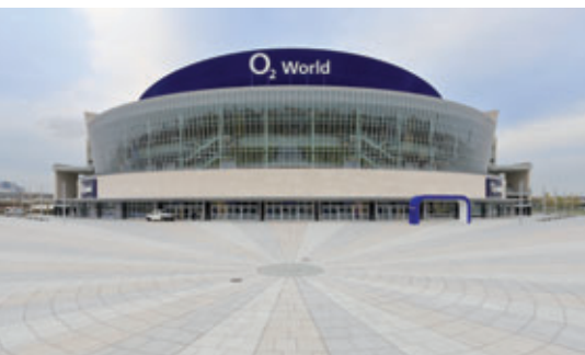
Projekt mit großformatigen Betonpflasterplatten
