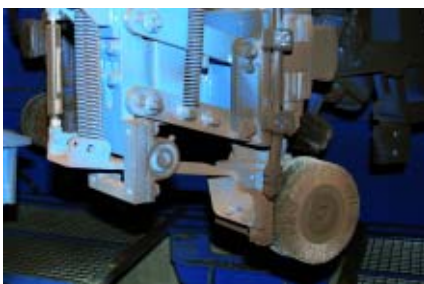
Стальные щетки снимают остатки бетона с поддонов
