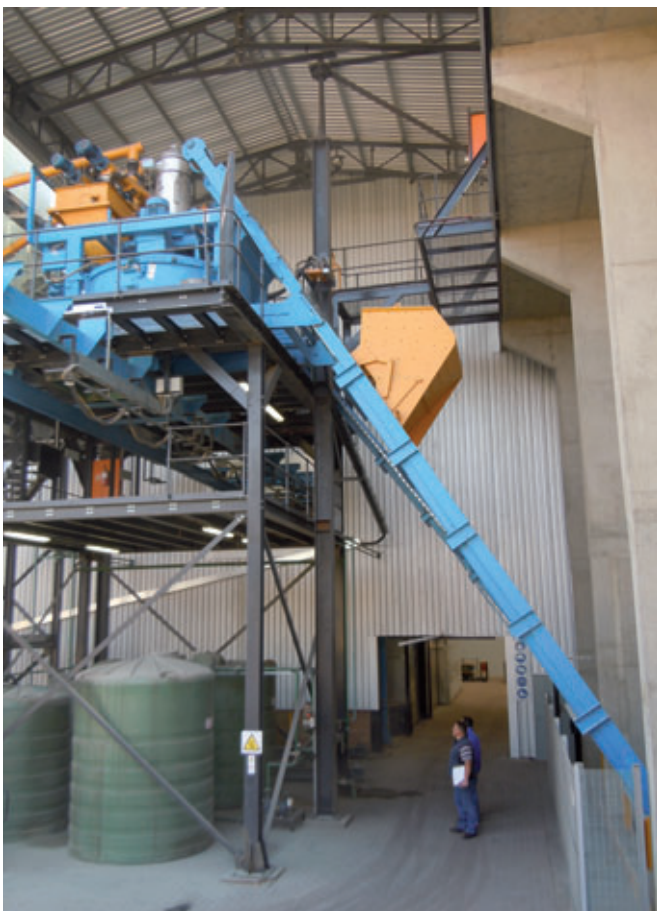
Impalcatura con i miscelatori orizzontali a regime forzato Masa PH 1500/2250 e PH 200/300
