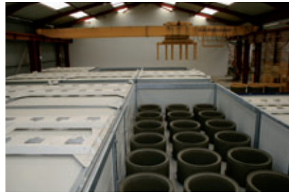
Gli anelli induriti del pozzetto poco prima del trasporto tramite la gru a comando automatizzato
