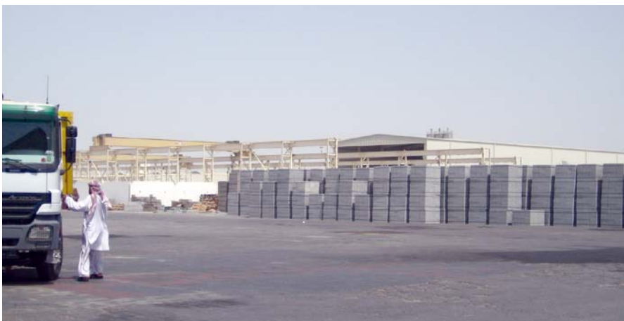
阿布扎比 Foresight 混凝土工业有限公司的日总产量为 100,000 块空心砖
