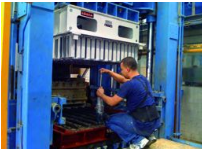
Форма Kobra установлена и готова к производству
