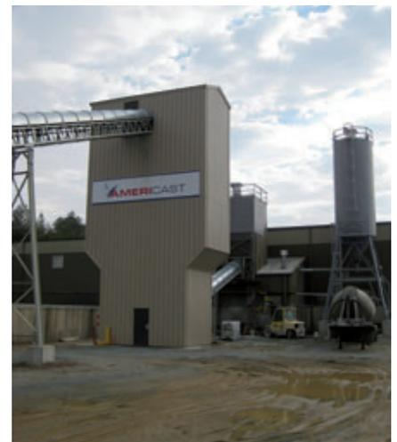
Lo stabilimento ad Ashland, in cui è stato installato l'impianto Exact1500 di Schlüsselbauer, dispone di quattro silos di 60 tonnellate per materiali inerti e di due ulteriori silos per cemento e cenere volante. È consentito sostituire fino al 25% del cemento con la cenere volante
