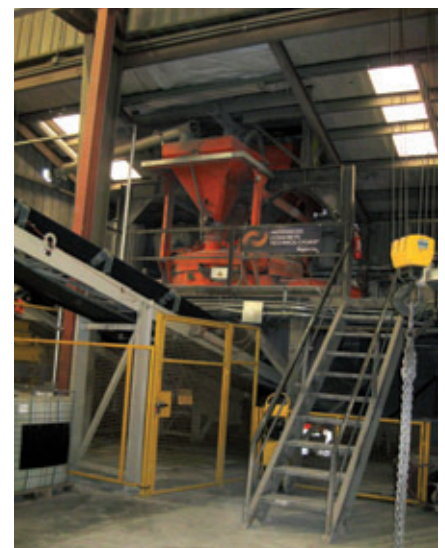
Mischer von ACT (Advanced Concrete Technology) mit 1,7 m 3 (2 yd 3 )
