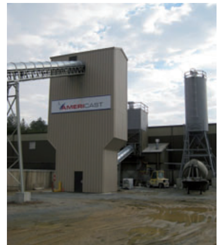
Das Werk in Ashland, in dem die Exact1 500 Anlage von Schlüsselbauer installiert wurde, verfügt über vier 60-Tonnen Silos für Zuschläge sowie über zwei weitere Silos für Zement und Flugasche. Es ist zulässig, bis zu 25 % des Zements durch Flugasche zu ersetzen.
