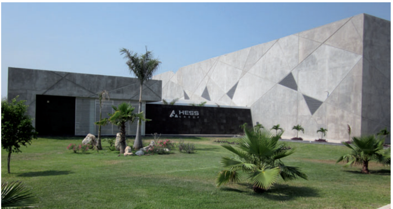
Die neue Hess-Fabrik wurde in einer modernen Betonarchitektur modular geplant, die den Hess-Slogan „Wir bringen Beton in Form“ auf den Punkt bringt
