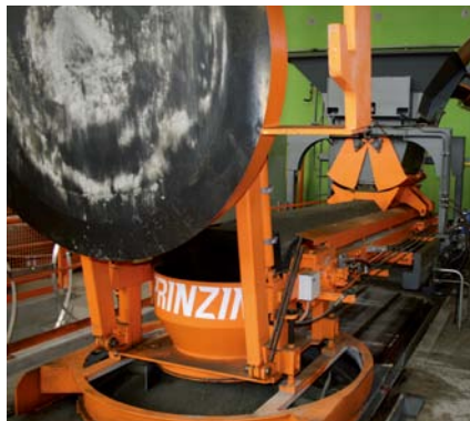
配料板对混凝土流量进行控制
