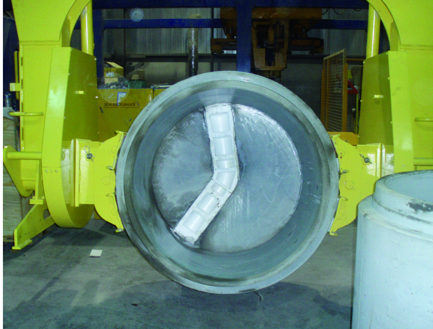
Распалубленные изделия поворачиваются в монтажное положение
