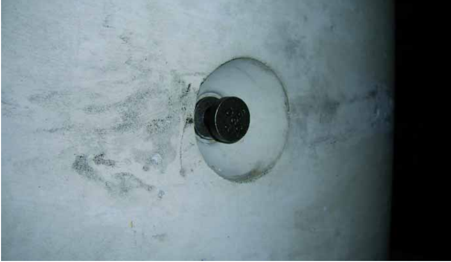
Замонеличаемые анкеры для безопасной транспортировки изделий на стройплощадке
