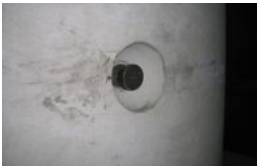
Zabudowane w trakcie zalewania formy kotwy zapewniają bezpieczny transport i montaż na budowie.
