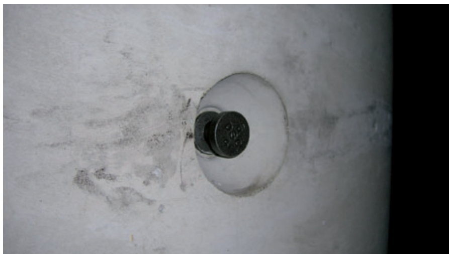
Tirante di ancoraggio colato per una manipolazione sicura dei prodotti in cantiere.
