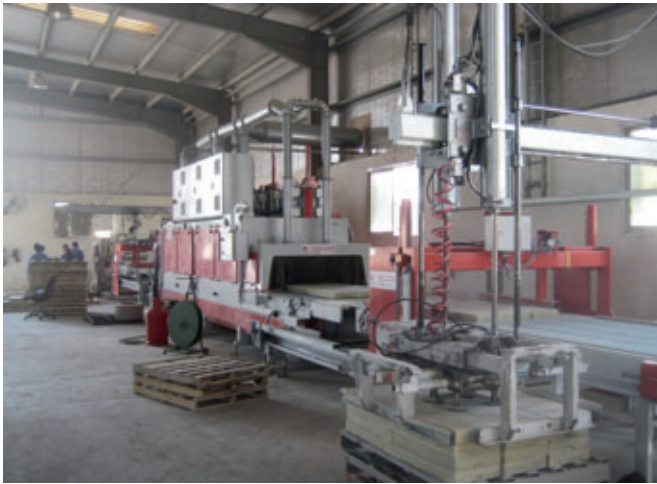
Impianto a spazzole presso Transgulf
