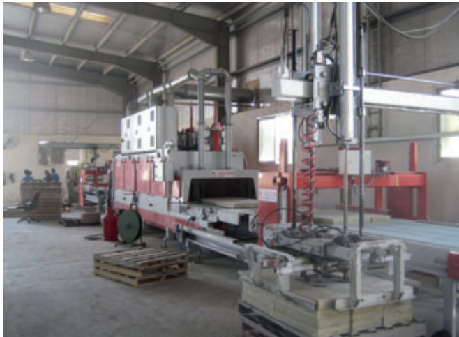
Installation de glaçage chez Transgulf
