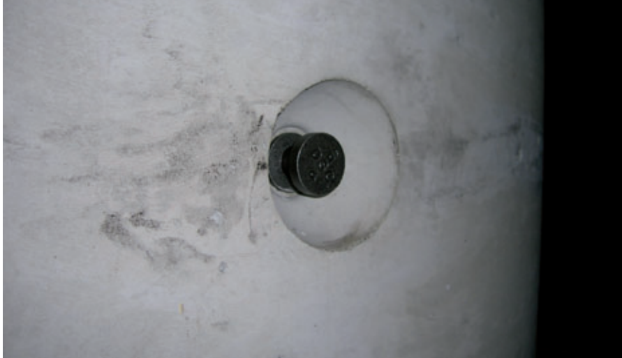
Eingegossene Anker für sicheres Handling der Produkte auf der Baustelle.
