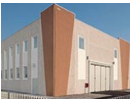
1, 2: Prefabrykaty betonowe dostarczone przez Stai Prefabbricati.
