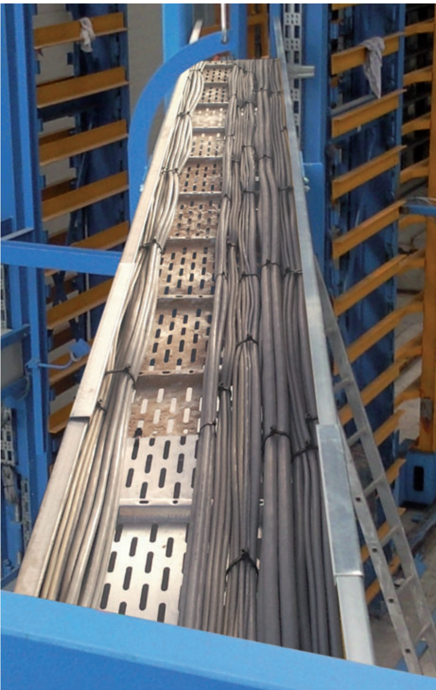
Pose des câbles dans des goulottes
