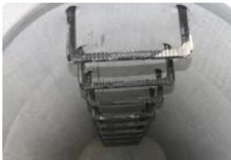
Szczelne włazowe wbijane są w dyble umieszczone w ścianie wyrobu.
