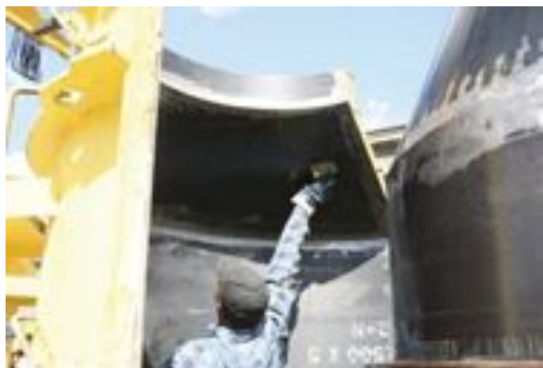
Smarowanie formy pastą adhezyjną Ortolan SEP 791 produkcji MC Bauchemie.
