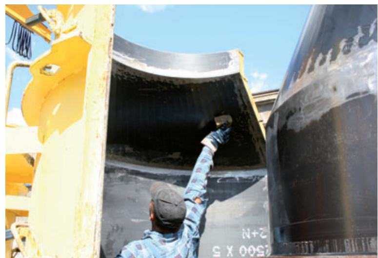
Lubrificazione delle superfici dell'armatura con pasta disarmante Ortolan SEP 791 di MC Bauchemie
