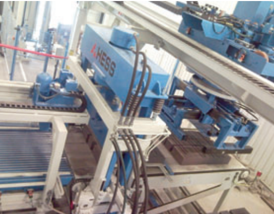
Les ébauches sont amenées sur une palette de transport jusqu'à l'installation de mise en paquet à servocommande; l'installation de mise en paquet s'empare d'un lit de blocs et les dispose sur la ligne de clivage
