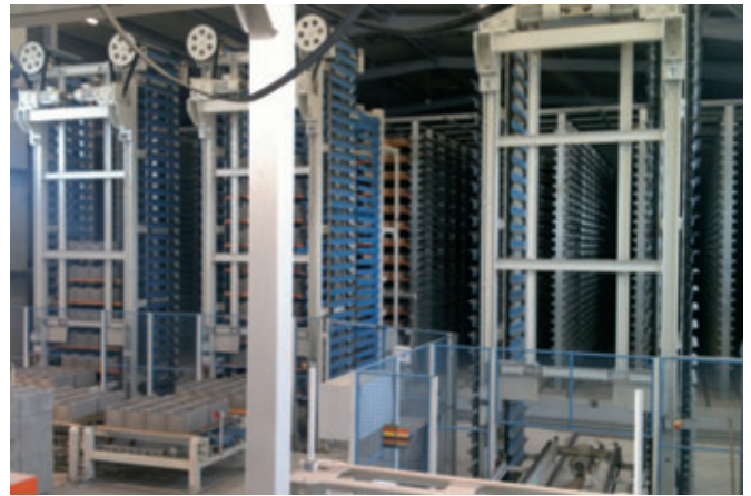
A gauche, les deux descenseurs; à droite, l'ascenseur
