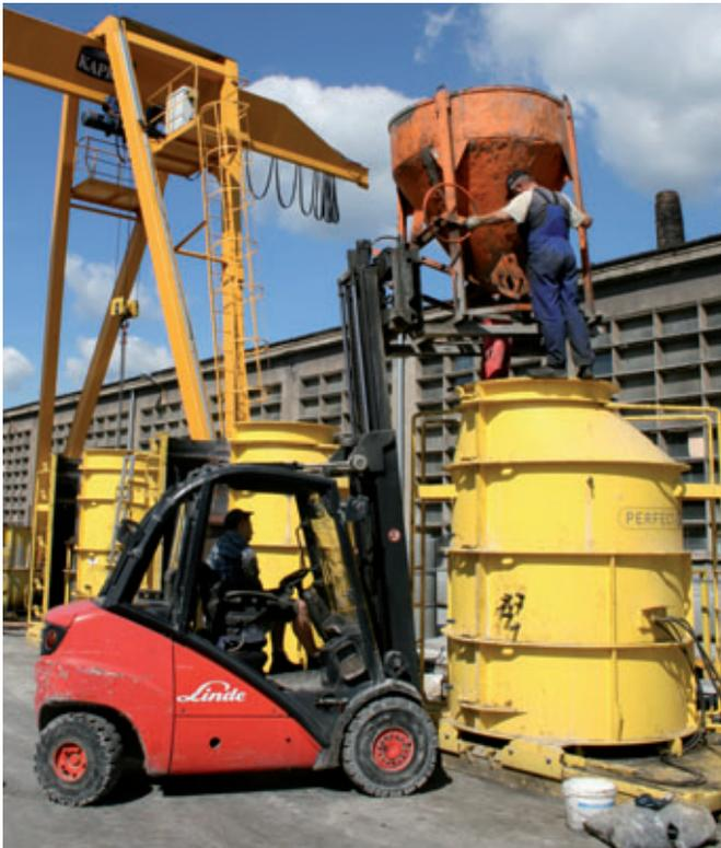
Le bétonnage est effectué au moyen d'un chariot élévateur et d'une benne à béton ; tout comme pour le système Perfect, seul du béton auto-plaçant est généralement utilisé.
