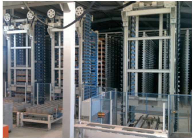
Links die beiden Senkleitern und rechts die Hubleiter
