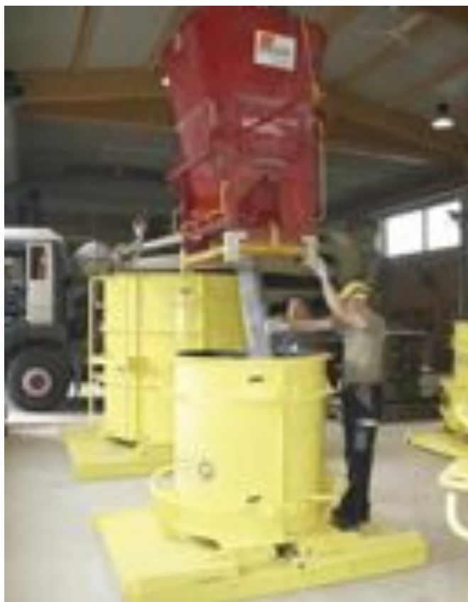
Betonowanie odbywa się za pomocą silosu.
