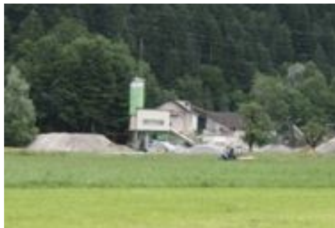
Beton dostarczany jest z pobliskiego zakładu.
