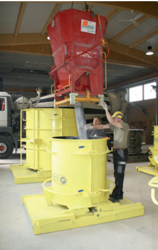
Betoniert wird mittels Betonkübel
